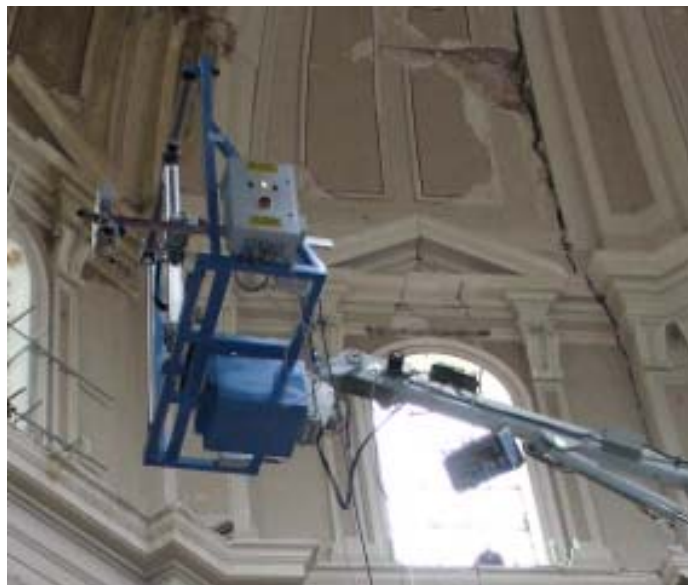
Robot installato sul braccio di una gru.
